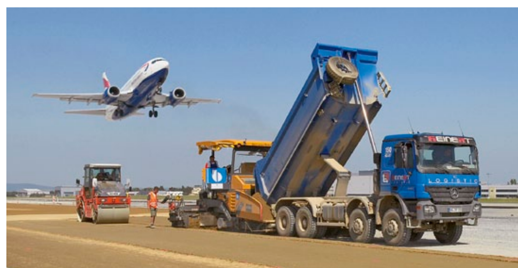
2007 - Sanierung und Verlängerung der Start- und Landebahn bei laufendem Flugbetrieb
