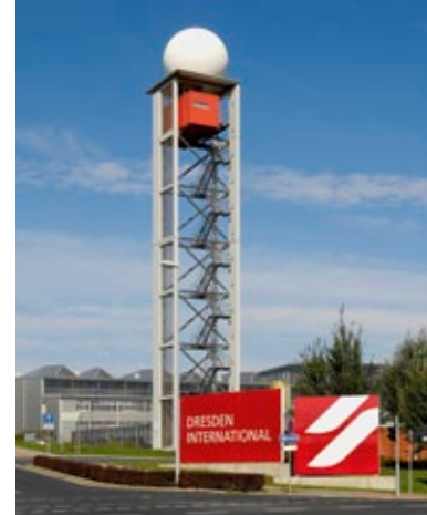
Wetterradarturn an der Terminalzufahrt
