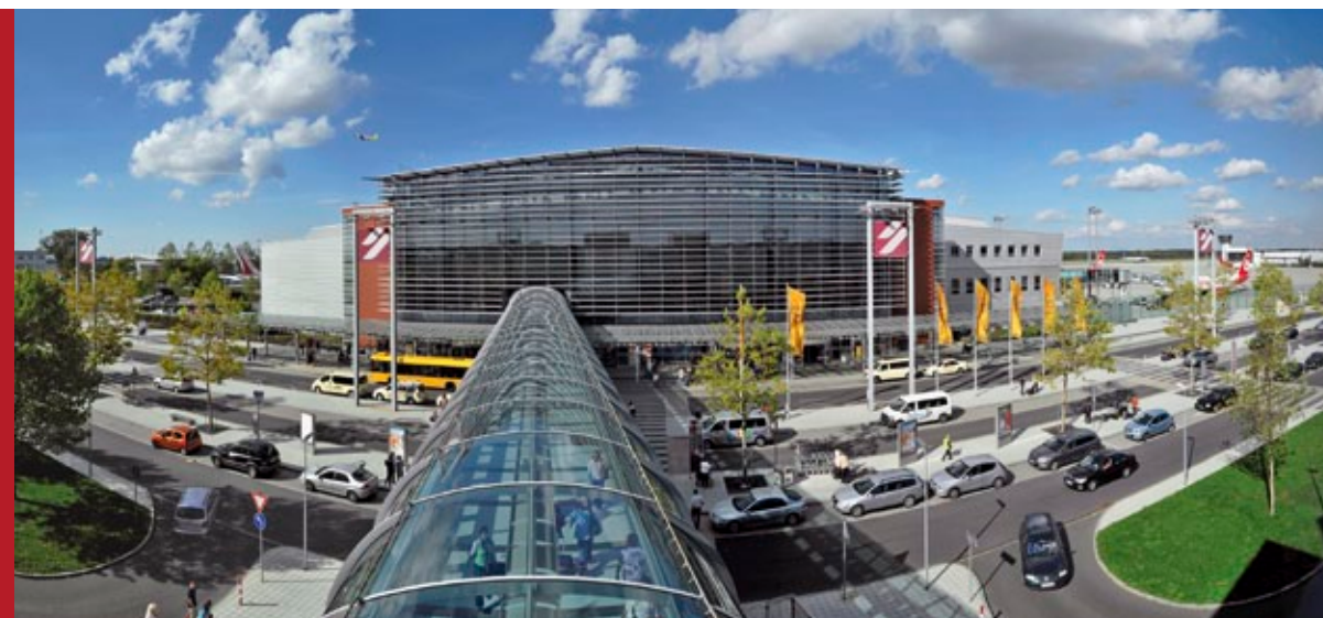
Das 2001 eröffnete Flughafen Dresden Terminal ist per »Skywalk« mit dem Parkhaus verbunden.
